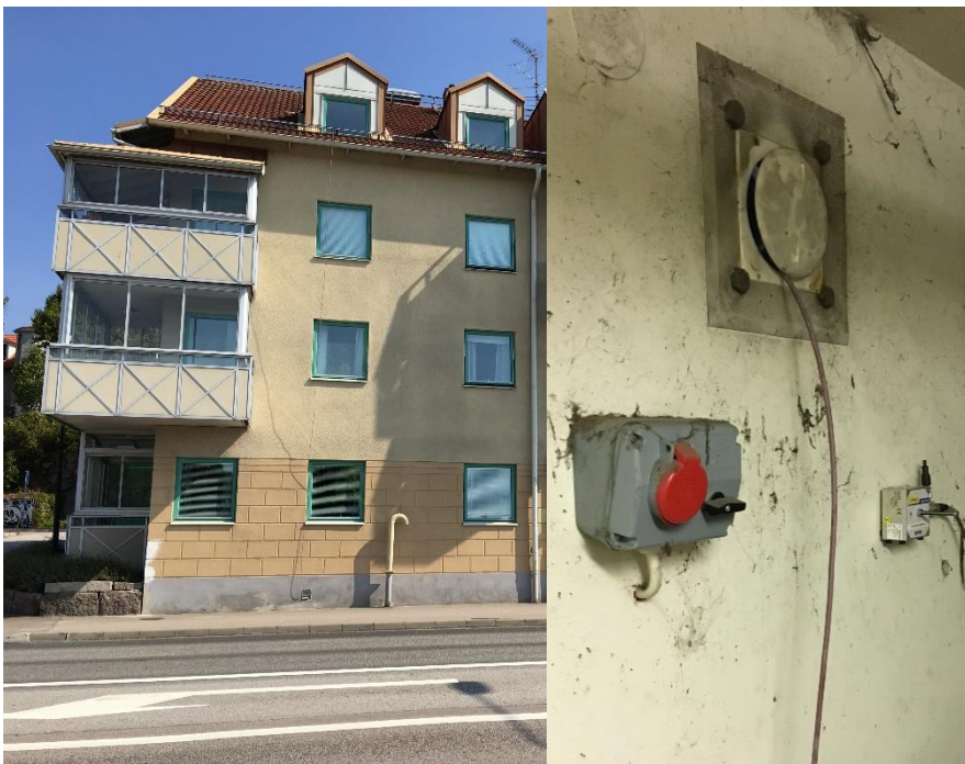
Figur 3: Givare monterad i källare för att kunna sortera ut relevanta vibrationshändelser
