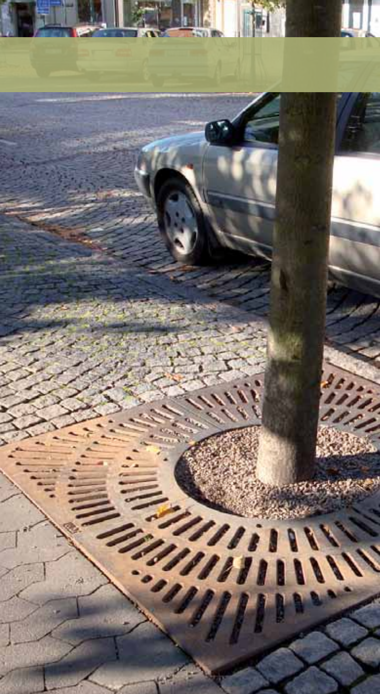
Det finns tre principer för att plantera träd - i marknivå med gjutjärnsgaller, i marknivå med inramning och upphöjt med granitkantsten.
