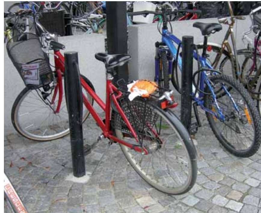
Traditionella cykelställ med stöd för framhjulet bör kompletteras med cykelställ som låter cyklisten låsa fast cykeln i ramen. En modell liknande den här kan användas. Exempel från stationen.
