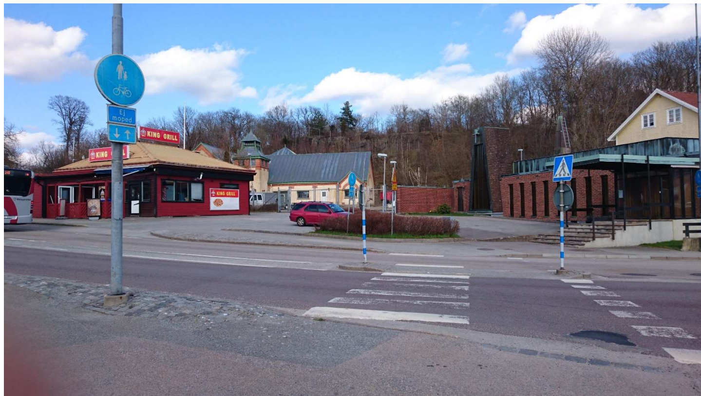
Foto från 2018-04-18 av gamla elverket från Kallingevägen med Pingstkyrkan till höger och kioskbyggnad till vänster i bild.
