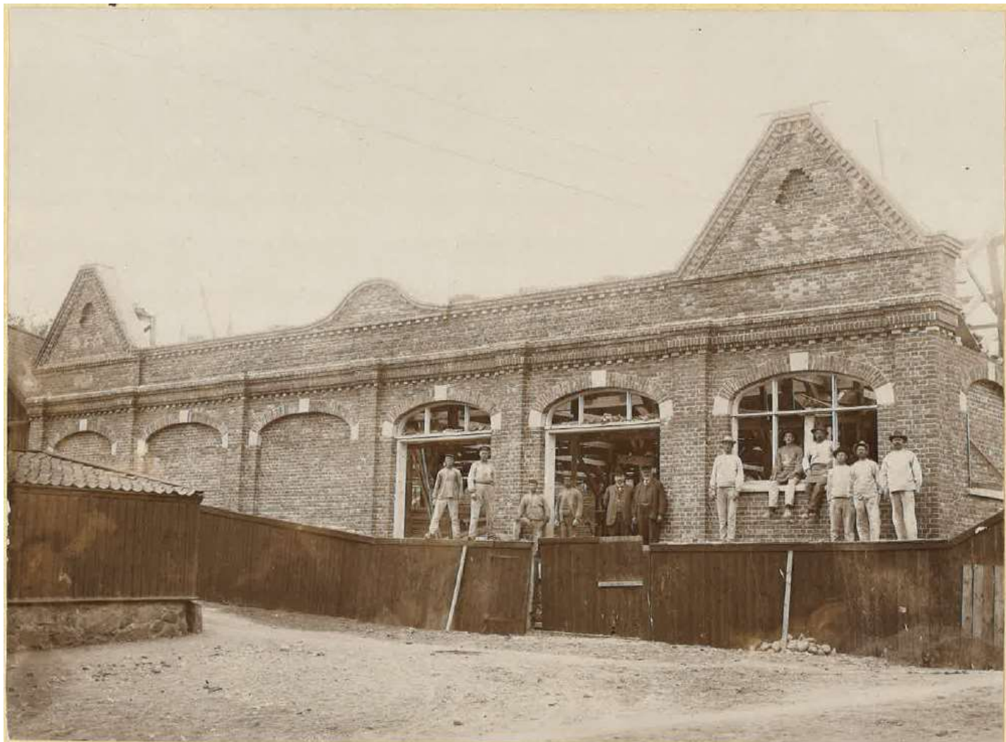
Fotografi från byggandet av Kockums emaljlager i dåvarande kvarteret Rolf, taget den 10 juni 1907. Foto ur Ronneby kommuns arkiv.
