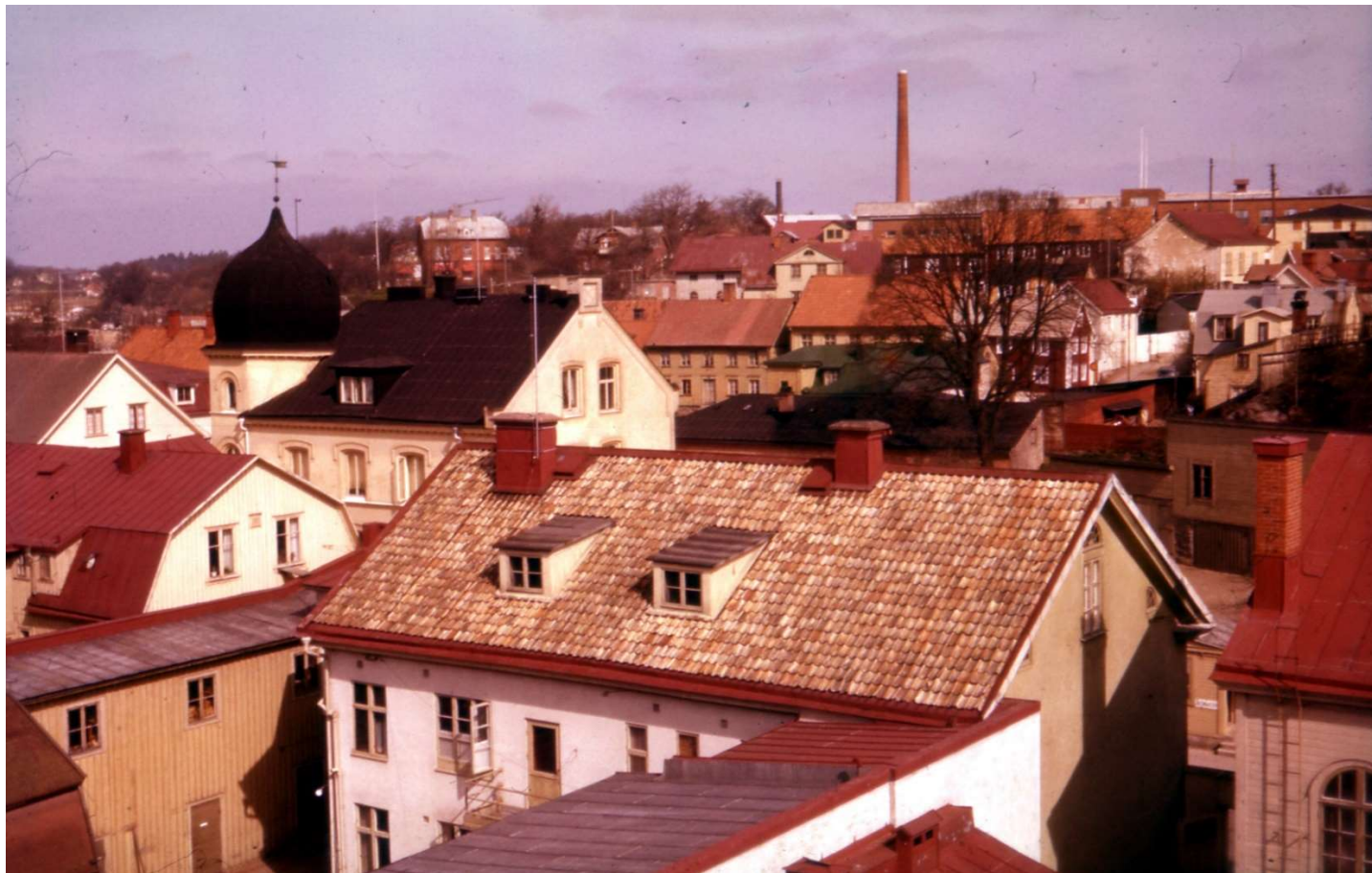
Fotografi från 1960 med den dåvarande kvartersbebyggelsen i förgrunden. Fotografiet är taget mot norr där skorstenen vid Kockums emaljverk kan ses i horisonten. Foto ur Blekinge museums arkiv.
