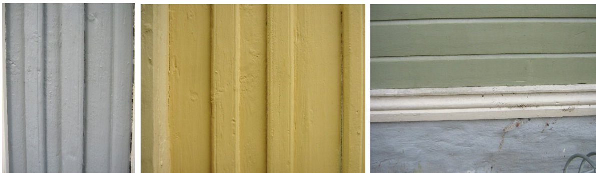
Exempel på tre olika fasadtyper med stående profilsågad listpanel samt liggande panel med avslutande profilsågad list mot husgrunden.
