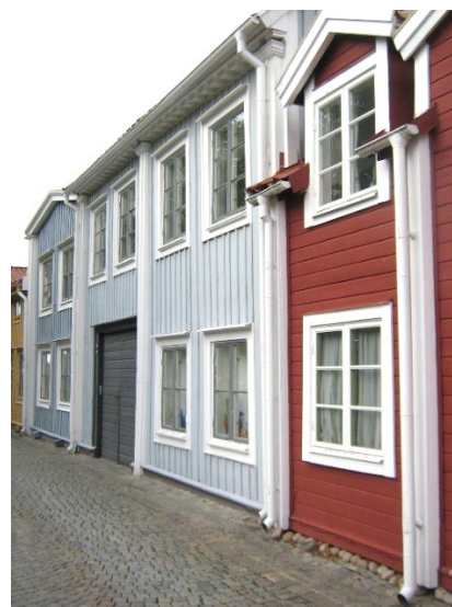
Exempel på bebyggelse med rötter i 1700-talet med låg stenfot och enkel rumsbredd.
