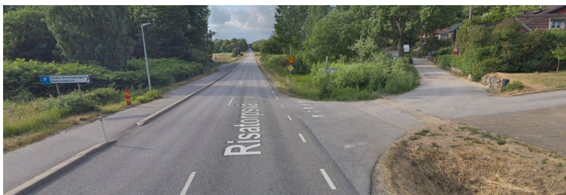
Bild 21. Nuvarande södra in- och utfart till planområdet från Risatorpsvägen. Vy mot norr.
