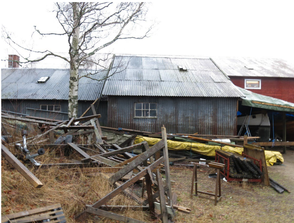
Fasad och tak av sinuskorrigerad plåt som är ett material med lågt underhållsbehov. Bild tagen av Katja Meissner Byggkult.
