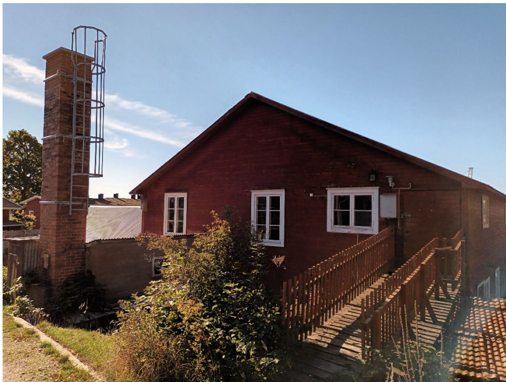
Varvsbyggnadens nordöstra sida som man möter när man kommer till varvet från landsidan.
